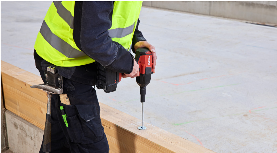
Abb. 2.3: Installation eines Betonschraubankers zur Befestigung eines Holzbalkens direkt durch das Holzelement am Beton
