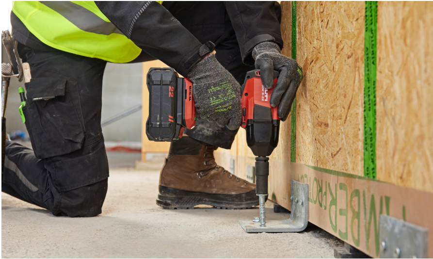
Abb. 2.2: Setzen eines Betonschraubankers zur Befestigung eines Holzrahmenwandelements am Beton mittels eines Stahlwinkels
